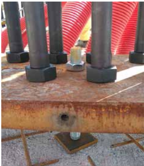
Slika 8. Dio donjeg armaturnog prstena sa navijenim anker vijcima
