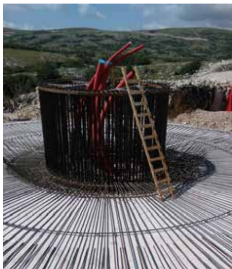
Slika 9. Armaturni prsten i anker vijci
