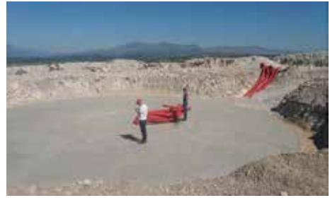
Slika 7. Podložni beton - VT5
