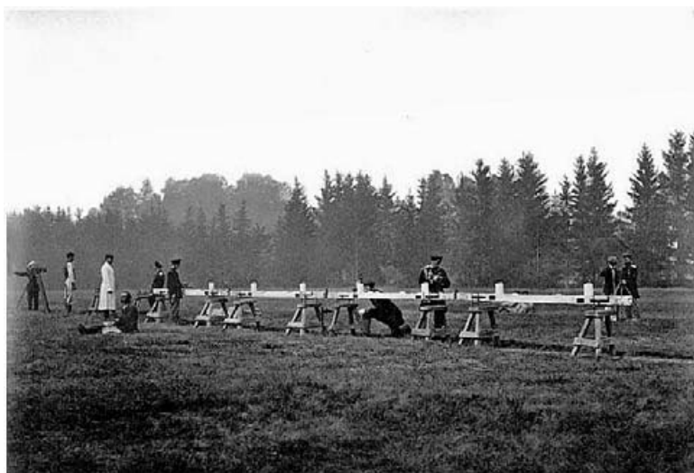
Slika 5. Mjerenje bazne linije (URL-7)
