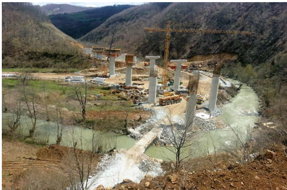
Slika 4. Isto mjesto – sada veliko gradilište
