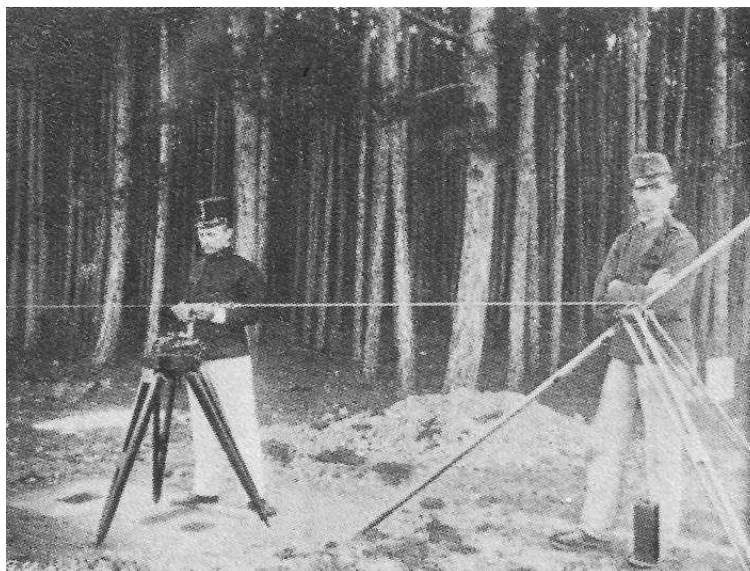
Slika 5: Mjerenje bazisne linije invarnim žicama (Messner, 1980.)
